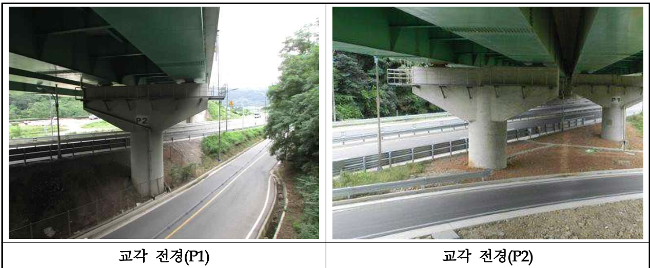
【사진 3.2.10】 교각 전경(대구)
