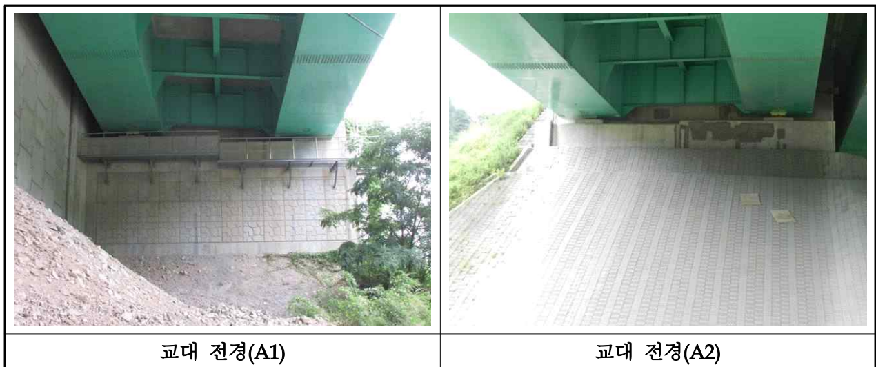
【사진 3.3.9】 교대 전경(부산)
