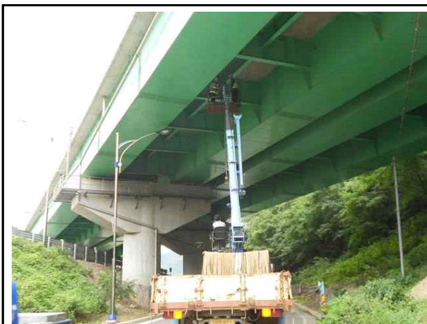
고소작업차를 이용한 조사
