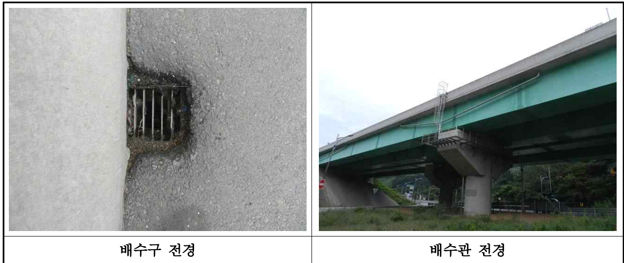
【사진 3.3.21】 배수구 및 배수관 전경(부산)
