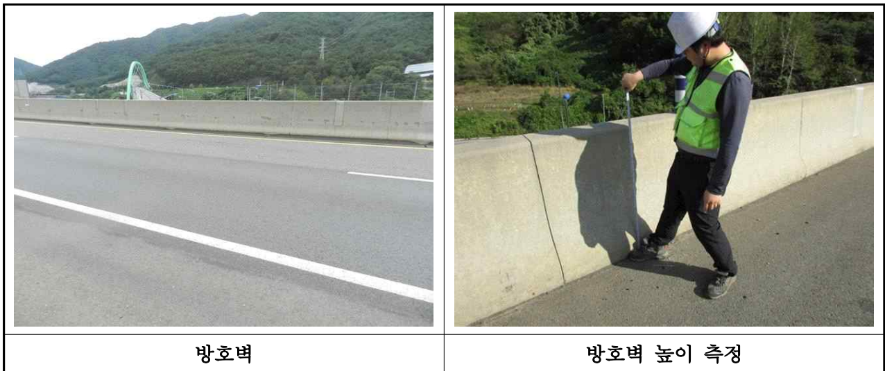
【사진 3.2.22】 난간 및 연석 전경(대구)
