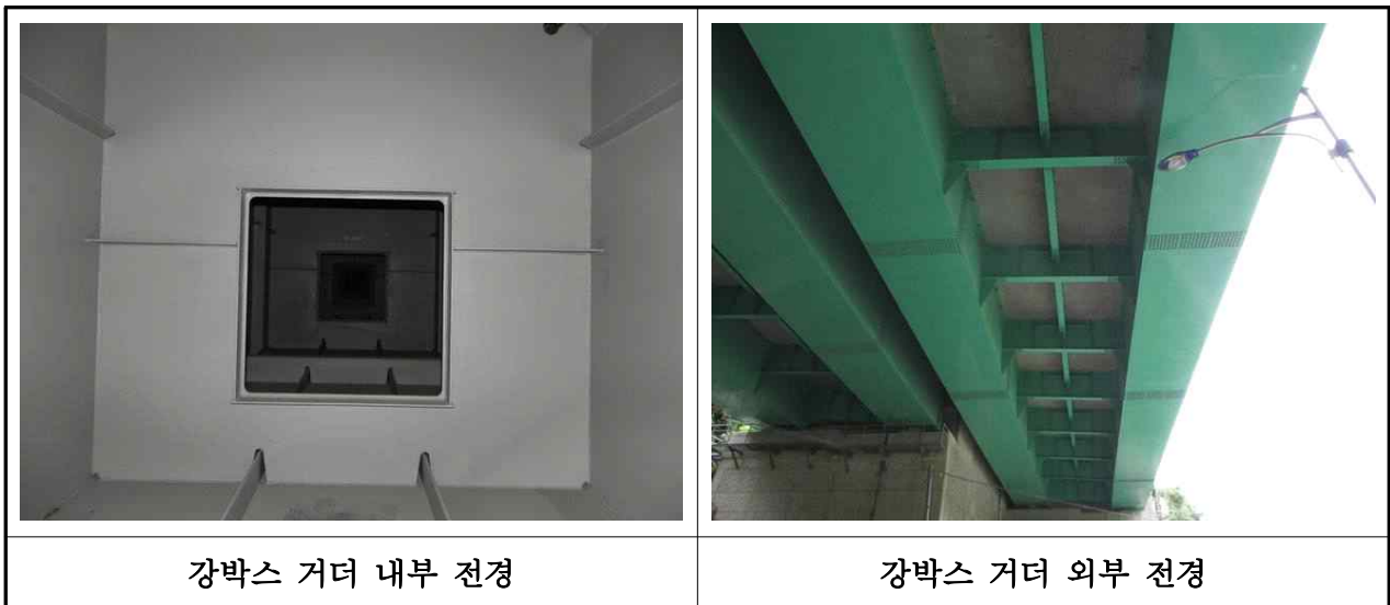
【사진 3.3.4】 강박스 거더 전경(부산)
