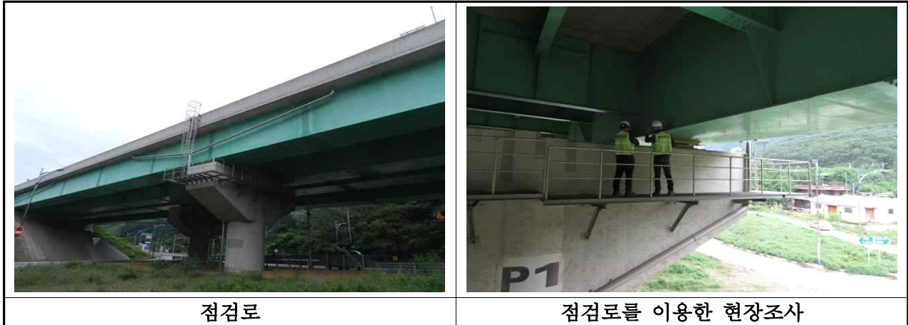
【사진 3.3.25】 점검시설 전경(부산)
