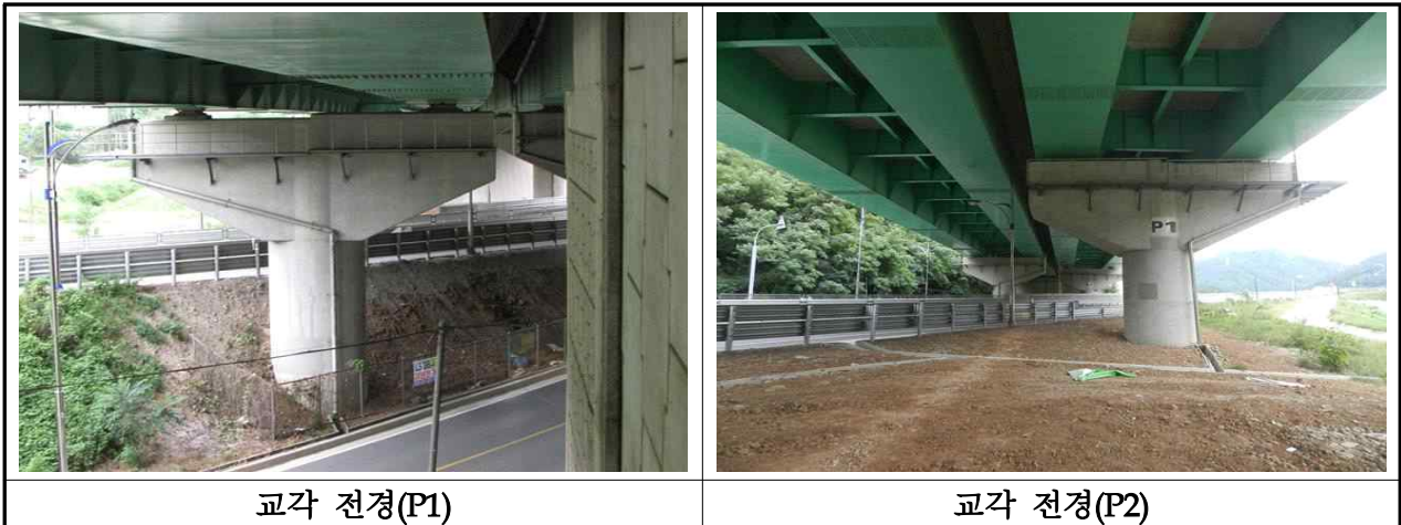
【사진 3.3.11】 교각 전경(부산)
