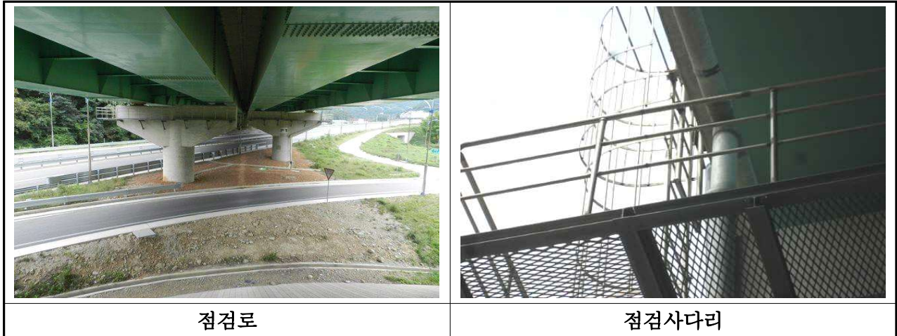
【사진 3.2.24】 점검시설 전경(대구)
