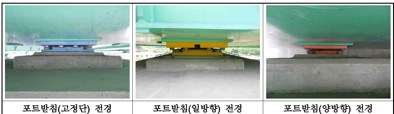
【사진 3.3.13】 교량받침 전경(부산)
