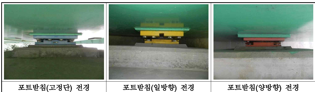
【사진 3.2.12】 교량받침 전경(대구)
